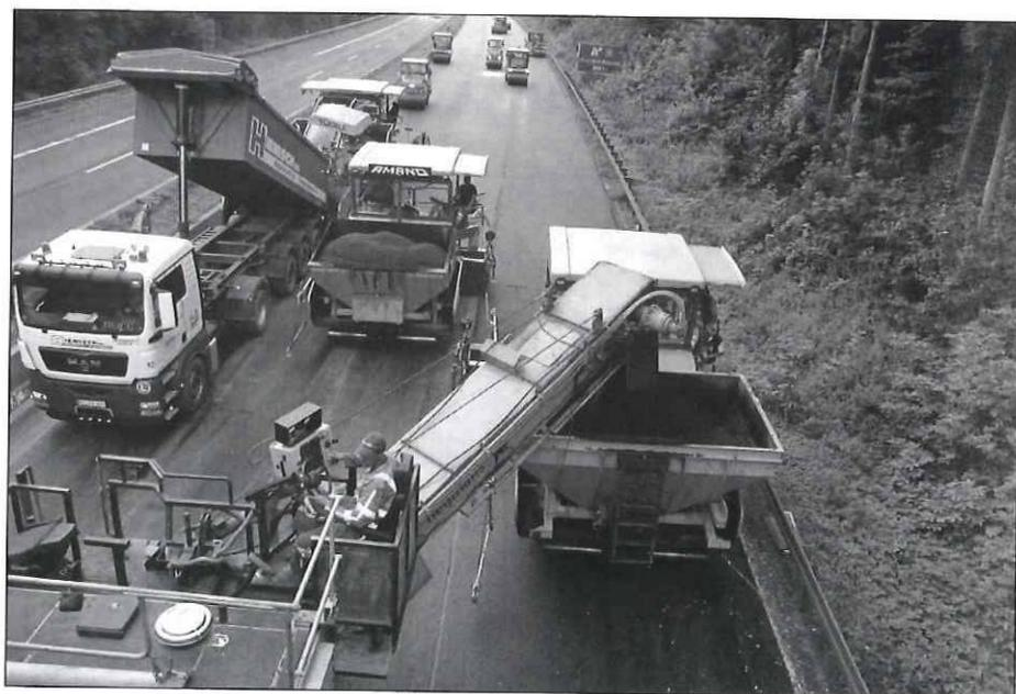
*Einbau des neuen Flüsterasphaltes auf der A40 in Fahrrichtung Essen*
